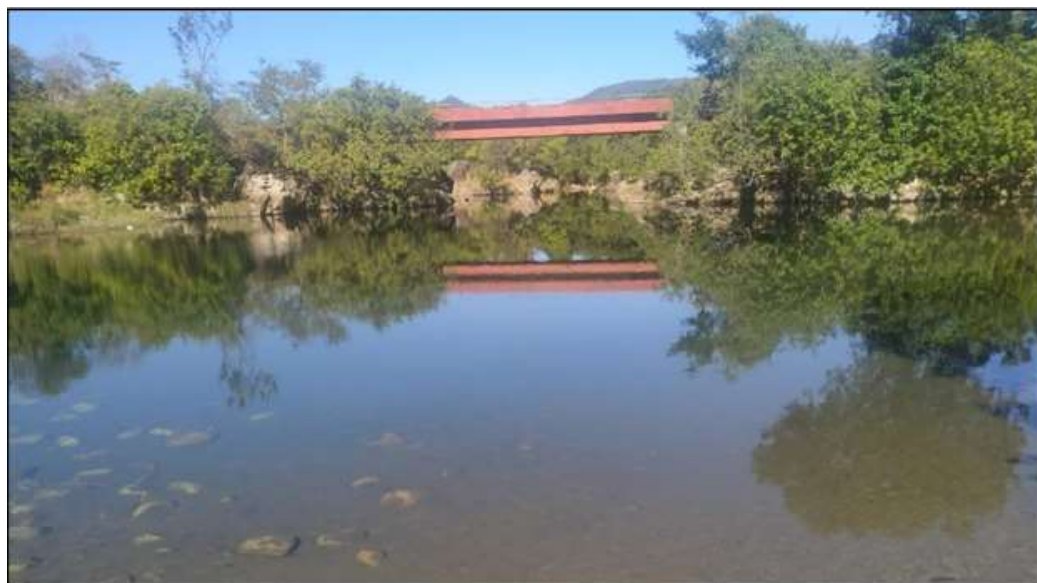
Figura 8 - Ponte sobre o Rio da Prata na região da Área 1
